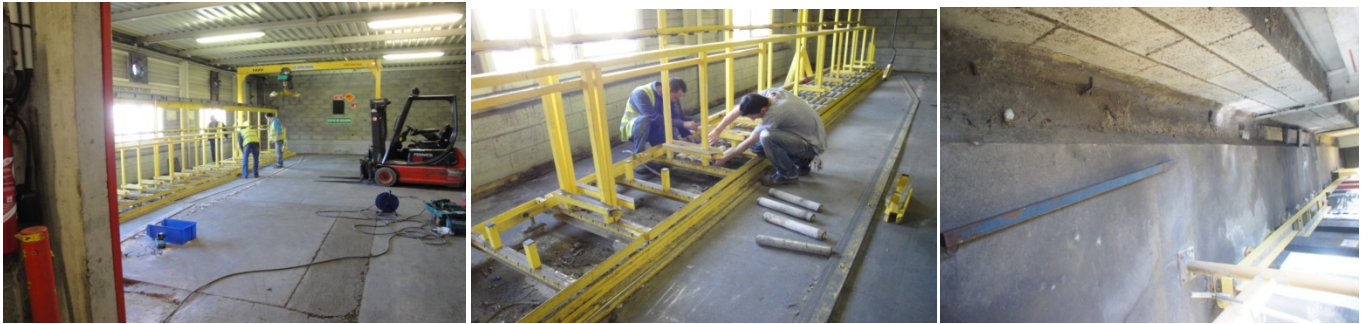
Démontage de l'ensemble du matériel et préparation arasage des fixations M12 nettoyage
