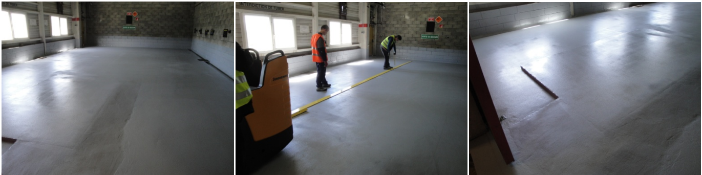
Réparation des fissures et rebouchage des trous avant revêtement résine de synthèse en Polyuréthane
